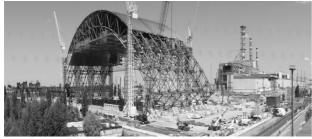
Рис. 1. После второго подъема восточной Арки НБК
